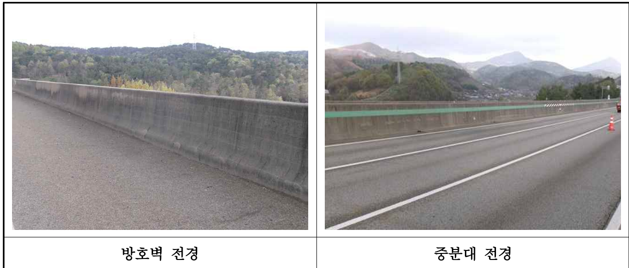
【사진 24.3.24】 방호벽 및 중분대 전경
