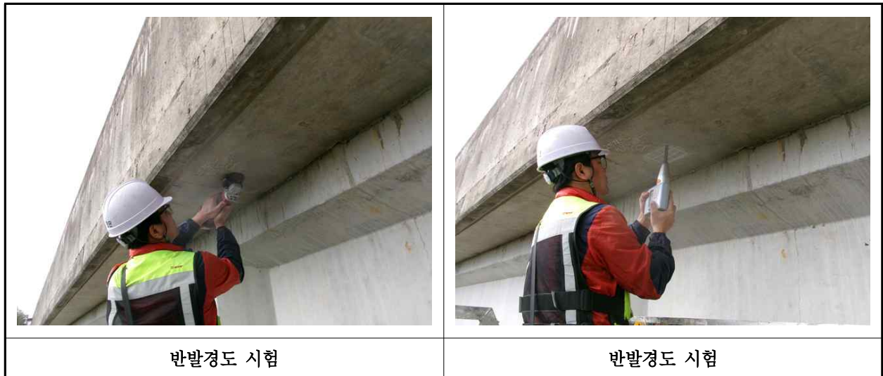
【사진 24.4.2】 반발경도시험 현장사진
