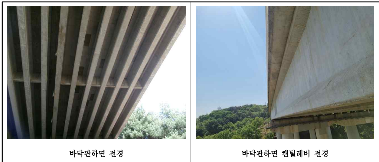
【사진 24.3.2】 바닥판하면 전경
