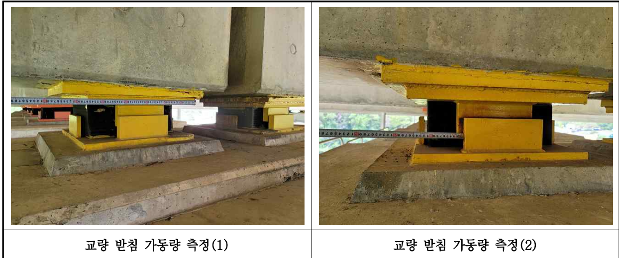
【사진 24.3.16】 교량받침 이동량 측정
