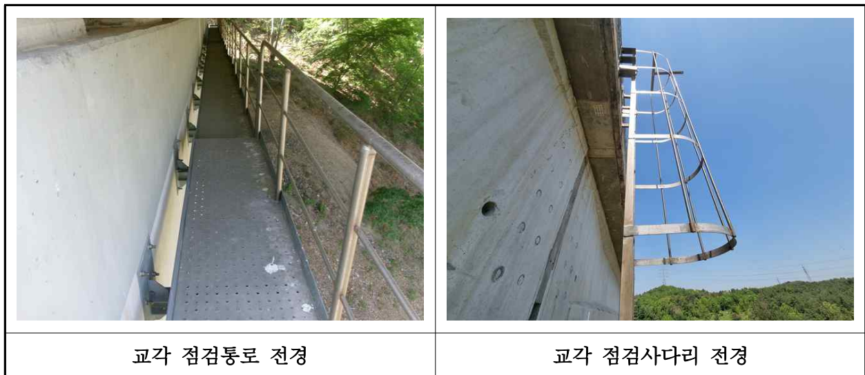
【사진 24.3.26】 교량 점검시설 전경
