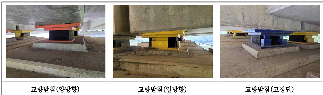
【사진 24.3.13】 교량받침 전경
