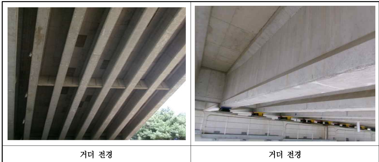
【사진 24.3.4】 거더 전경
