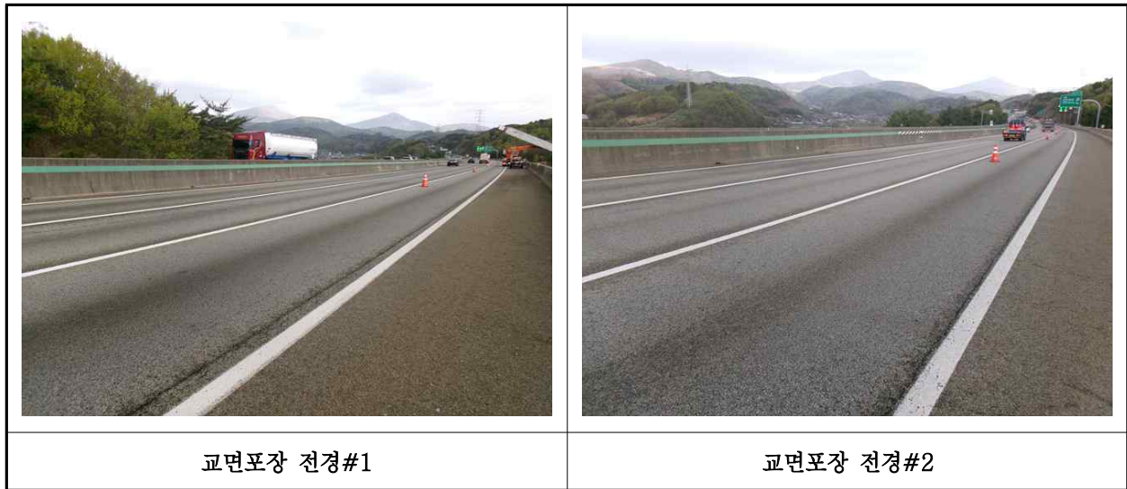
【사진 24.3.20】 교면포장 전경
