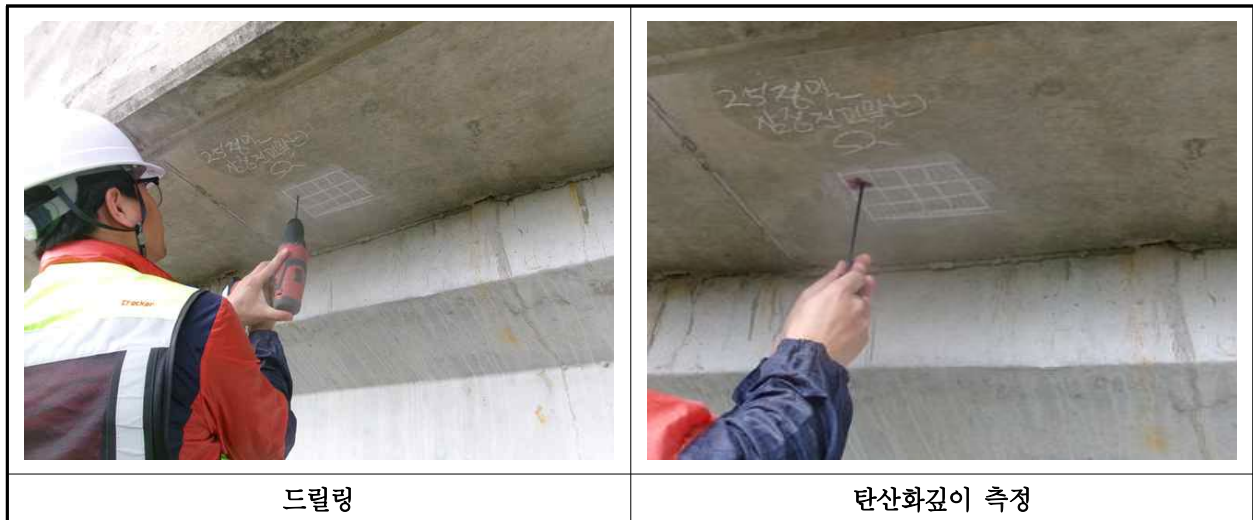
【사진 24.4.3】 탄산화 깊이 측정 현장사진
