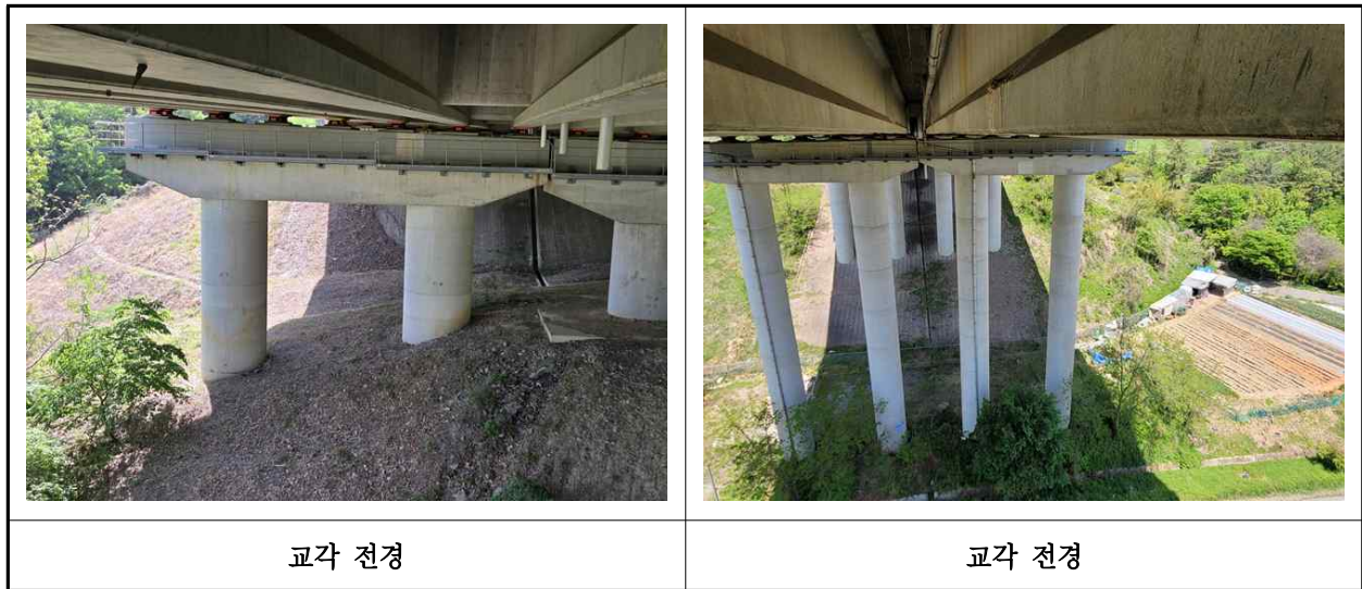
【사진 24.3.10】 교각 전경
