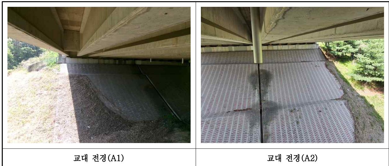
【사진 24.3.8】 교대 전경
