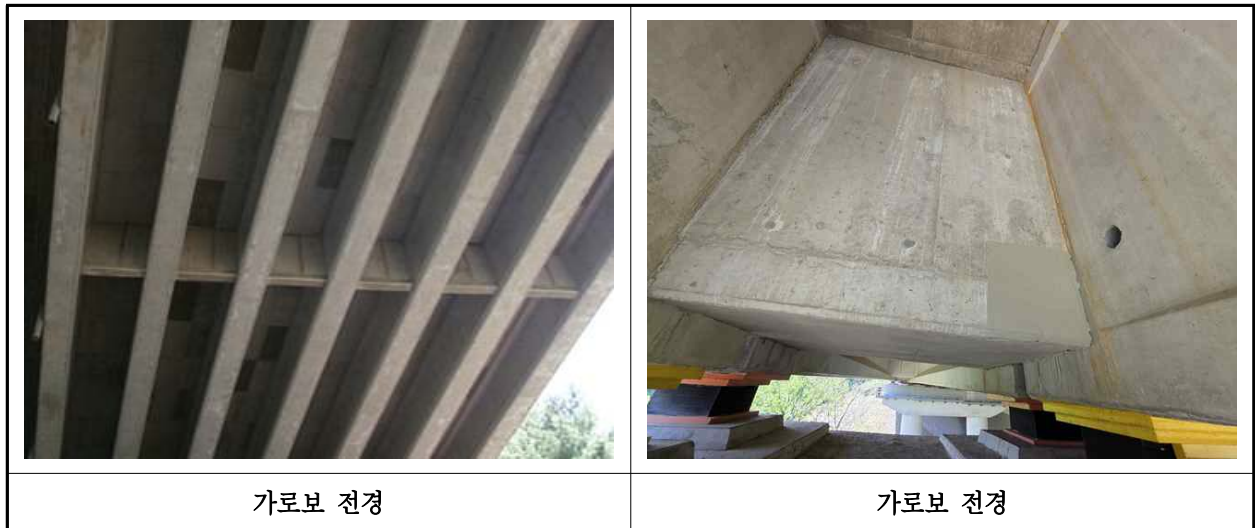
【사진 24.3.6】 가로보 전경
